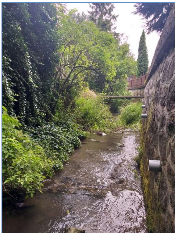
6. ábra. A Nagyfej-patak a község belterületén, bélésfalas partvédelemmel.
