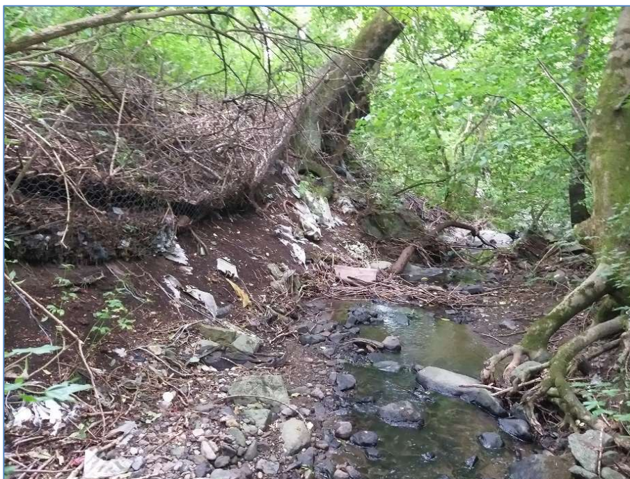
12. ábra. Műanyag, humusz talaj réteges keveréke a bal parton: 12+160
