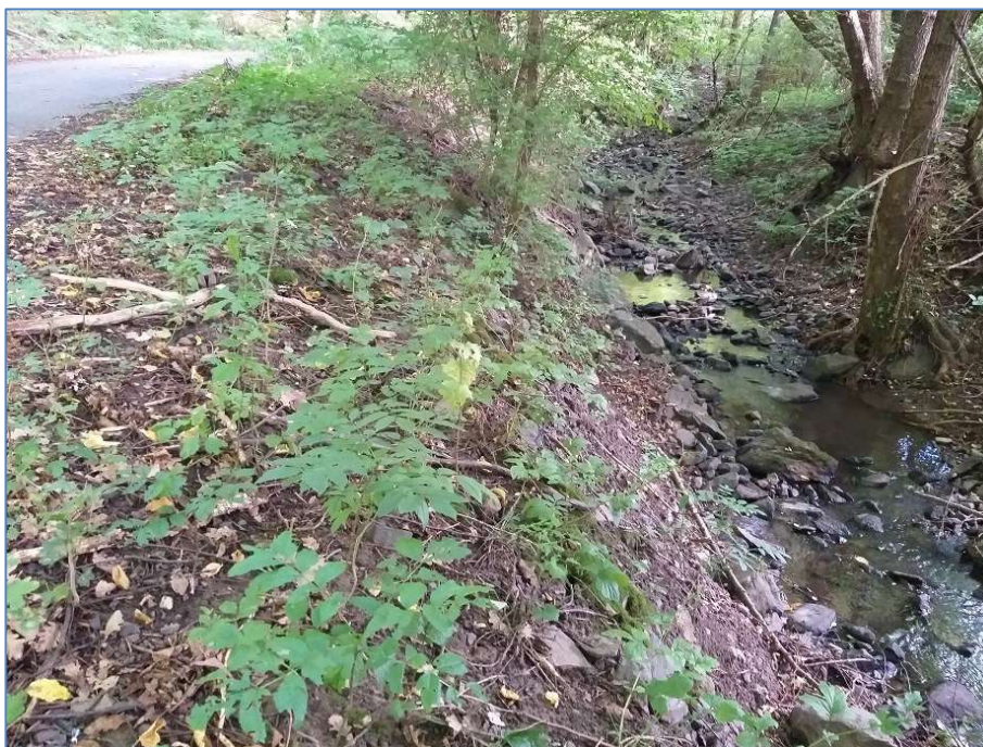
49. ábra. Külön kőrakatos parvédelem ott javasolt az alsó szakaszon, ahol a meanderező patakmeder megközelíti a műút földművét is.
