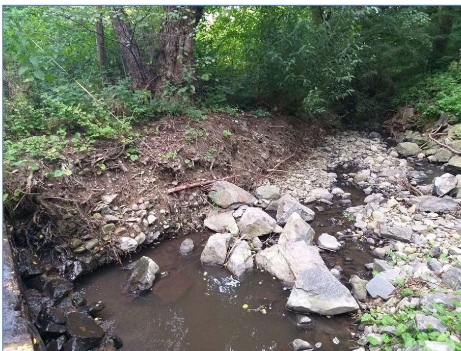
40. ábra. Fenékküszöb utáni hordaléklerakódás a belterületi határnál: 11+200
